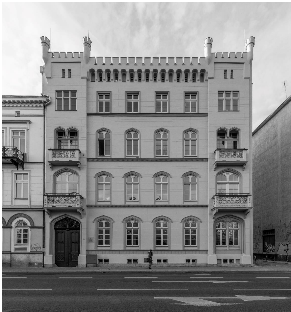
Rysunek 1. Widok na elewację budynku Maćków pracownia projektowa [autor: Maciej Lulko, materiał udostępniony przez Maćków Pracownię Projektową]
